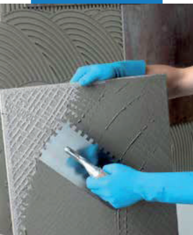
Нанесение Ultralite S1 (Ультралайт S1) на тыльную сторону плит
