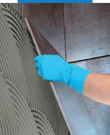
Укладка плит крупного формата на стены
