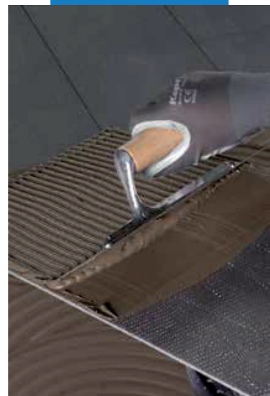
Нанесение клея на тыльную сторону плит
