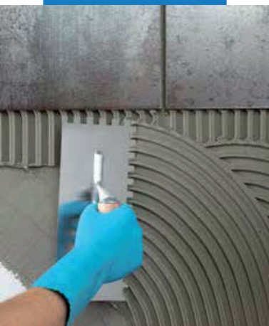
Нанесение Ultralite S1 (Ультралайт S1) зубчатым шпателем на стену
